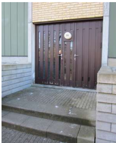
Adgang til trappeopgang
